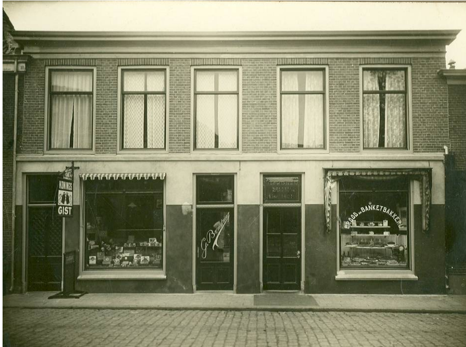
(24) Hier het resultaat van de ingrijpende verbouwing door bakker Bronstring van het oorspronkelijke Rutgers-pand (afb. 13) (voetnoot 107). Foto ± 1920: Archief Barneveld.
